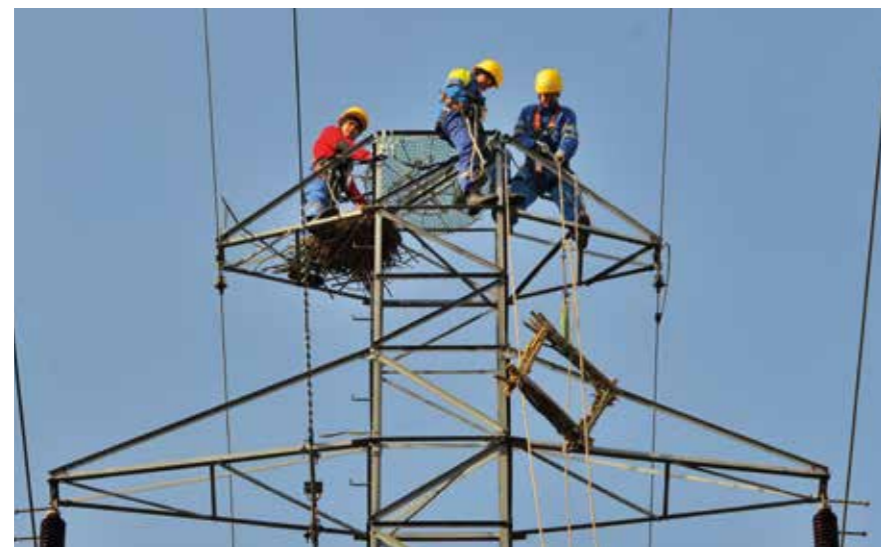
» ENEA OPERATOR, ELEKTROMONTERZY Z ENEI OPERATOR INSTALUJĄ PLATFORMĘ POD GNIAZDO DLA RYBOŁOWA NA SŁUPIE WYSOKIEGO NAPIĘCIA.
