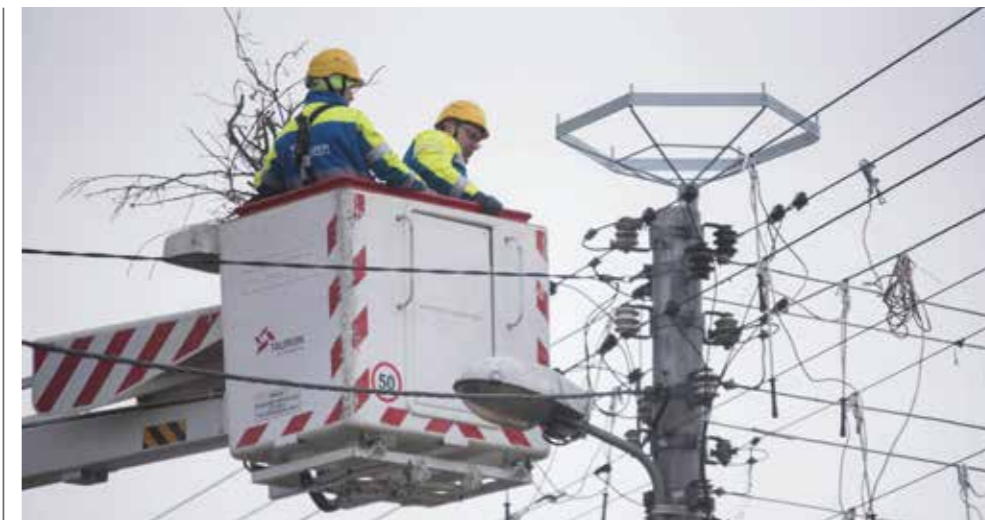
» TAURON DYSTRYBUCJA, MONTAŻ PLATFORMY DLA BOCIANÓW
