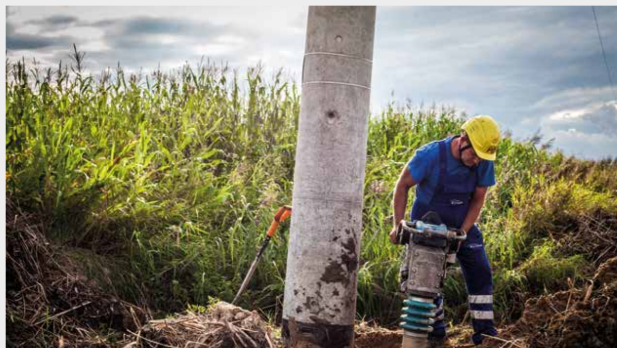
⚡ ENEA OPERATOR, PIONOWANIE SŁUPÓW ELEKTROENERGETYCZNYCH W OKOLICACH CZERNIEJEWA (WOJ. WIELKOPOLSKIE)
